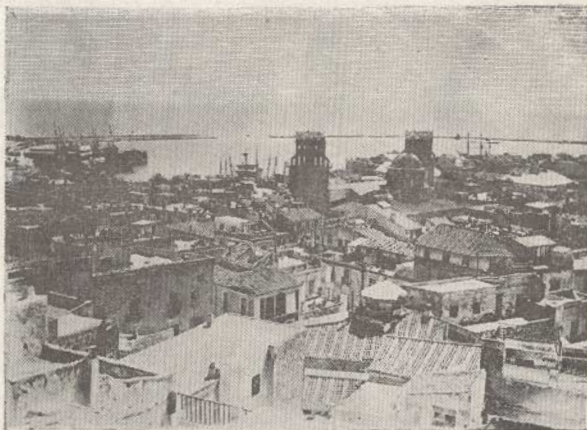
Alicante.—Vista parcial panorámica
